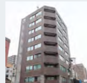
トータテ本社ビル 新社屋完成 1989年(平成元年12月)
